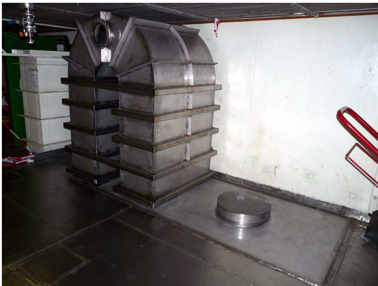
Obr. 1.4-1 Sifonové uzávěry na trase vzduchotechnických systémů
