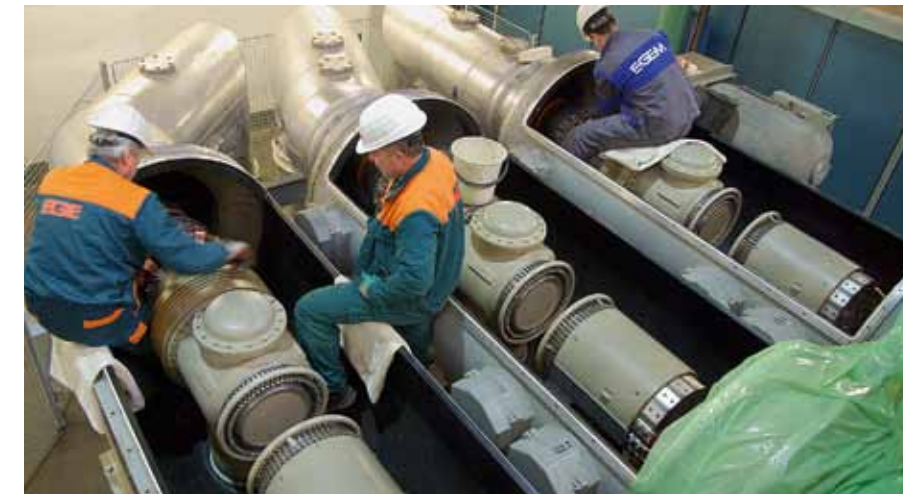
Pracovníci EGE s. r. o. (subdodavatel I & C Energo) při montážních pracích na zapouzdřených vodičích vyvedení výkonu
