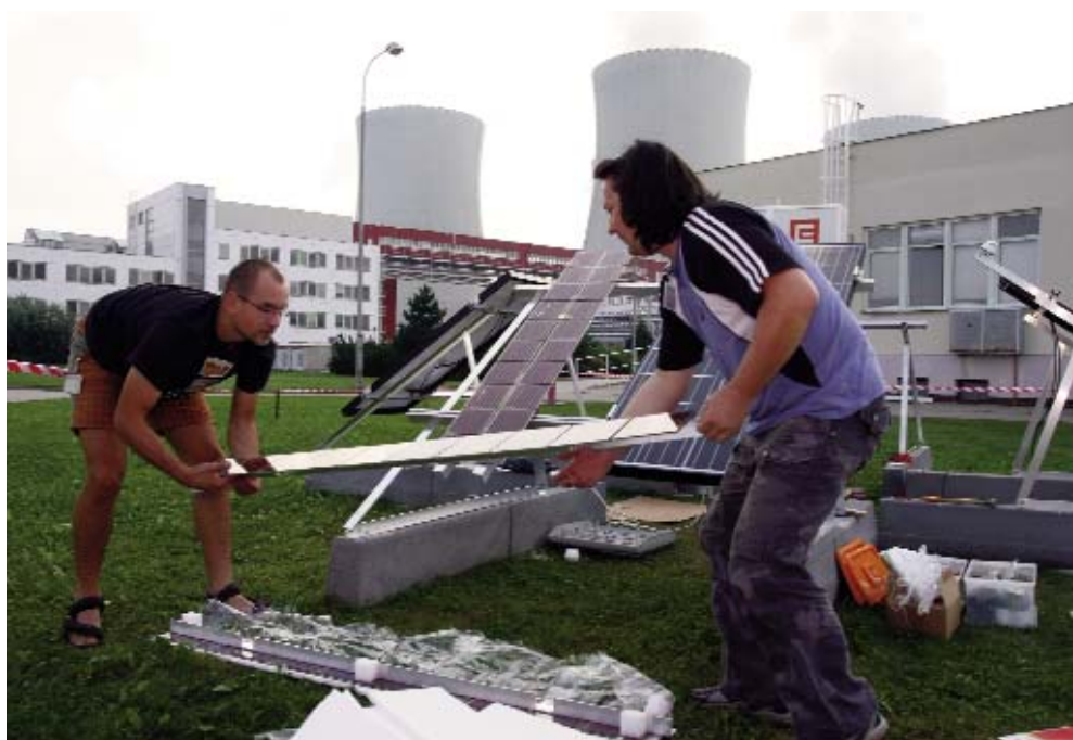
Fotografie z montáže testovacího pracoviště v areálu elektrárny Temelín
