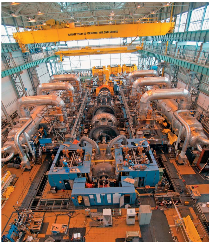
Na fotografiích vidíme montážní ruch na strojovně prvního bloku, kde se provádí výměna nízkotlakých rotorů a olejové regulace turbíny. Stejný ruch čeká Temelín v roce 2015 na druhého bloku.
