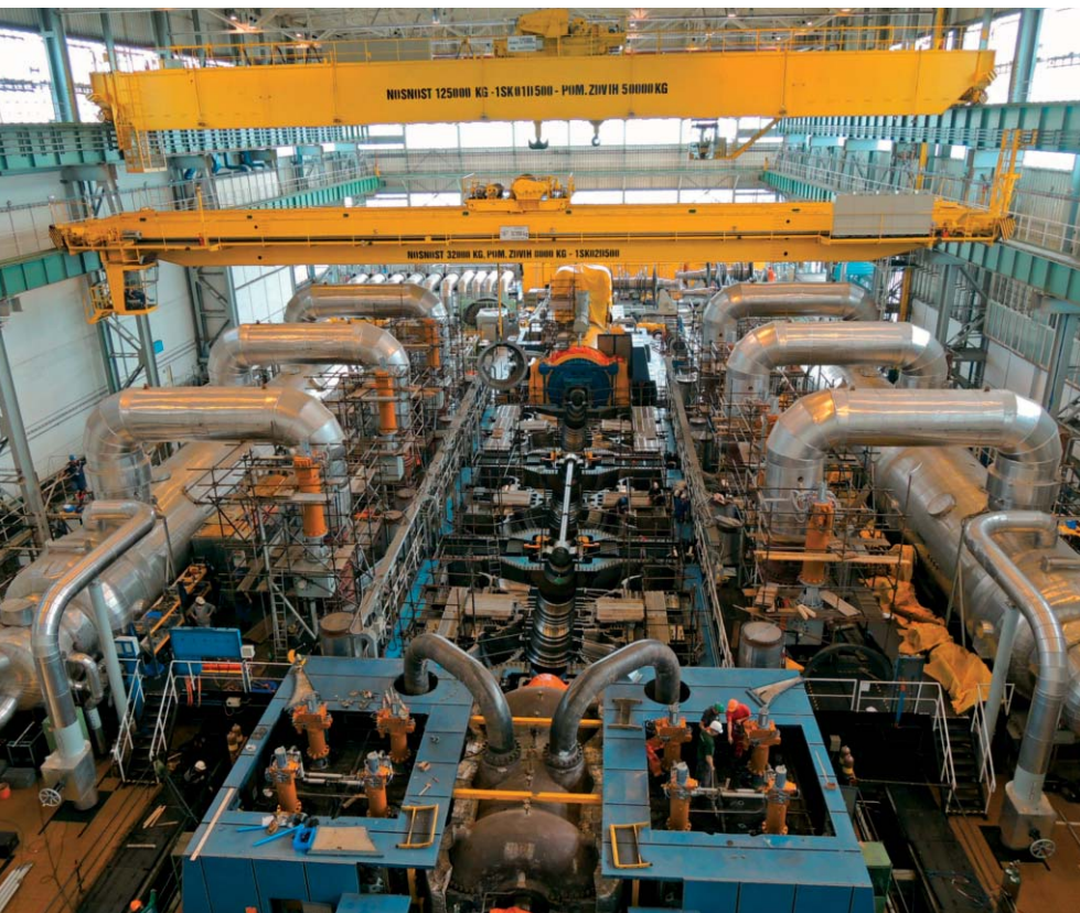
Pohled na turbínu prvního bloku elektrárny Temelín ve chvíli, kdy byly demontovány původní nízkotlaké rotory a byla zahájena montáž spodních statorových částí.
