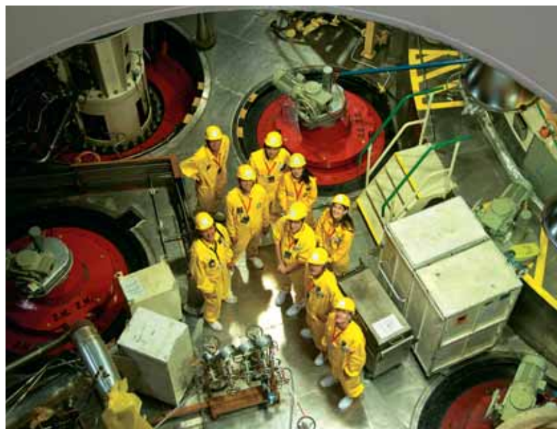
Prohlídka zařízení 1. reaktorového bloku, který byl v době Letní univerzity v plánované odstávce
