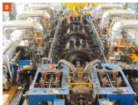
5 ▲ UKONČENA MONTÁŽ ROTORU VRCHNÍCH ČÁSTÍ
