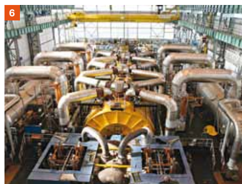
6 ▲ UKONČENA MONTÁŽ VRCHNÍCH ČÁSTÍ TURBÍNY
