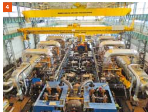
4 ▲ PŘÍPRAVA MONTÁŽE ROTORU
