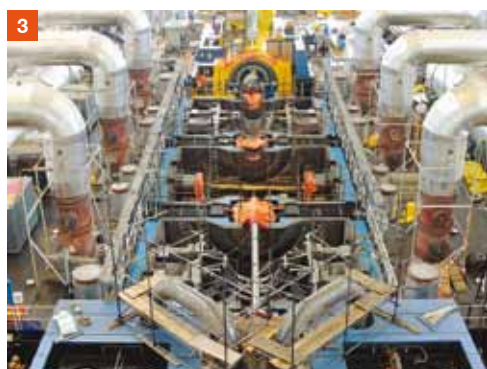
3 ▲ ZAHÁJENÍ ZPĚTNÉ MONTÁŽE
