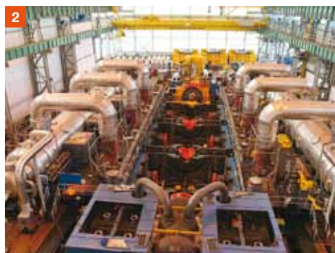
2 ▲ DEMONTÁŽ SPODNÍCH ČÁSTÍ
