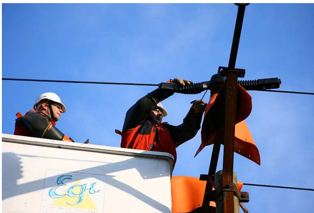
Montáž ochranného prvku Ensto technikou PPN (práce pod napětím)
