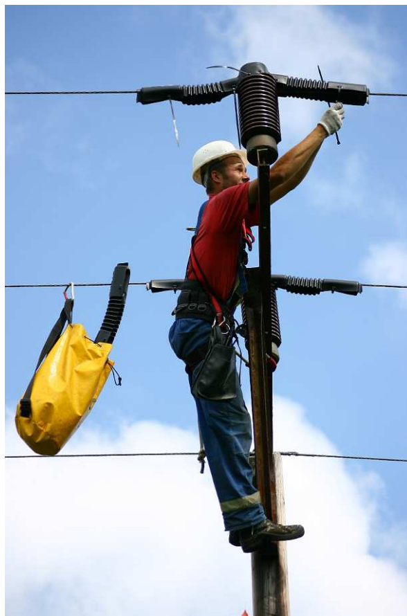
Montáž ochranného prvku Ensto
