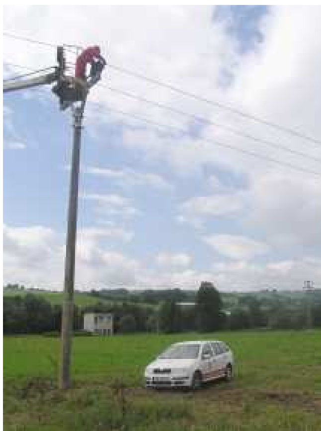
Montáž ochranných zařízení na vedeních ČEZ Distribuce
