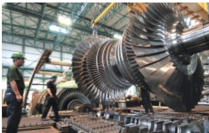
Usazování nízkotlakého rotoru turbogenerátoru do stroje
