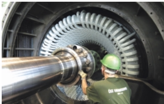
Nasouvání rotoru generátoru do statoru
