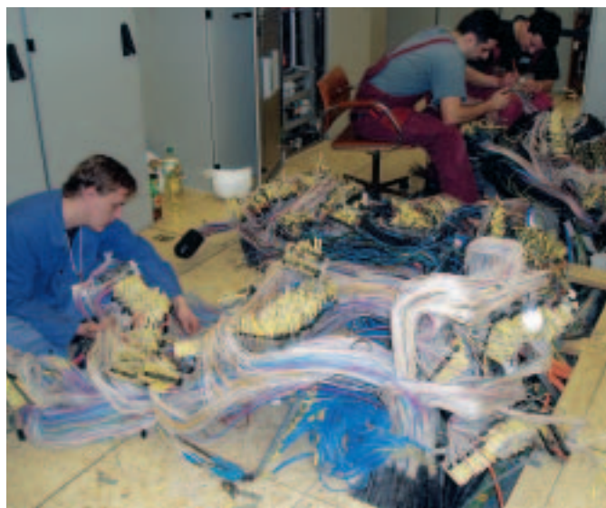
Práce na kabeláži představovala opravdu nadlidský úkol.
