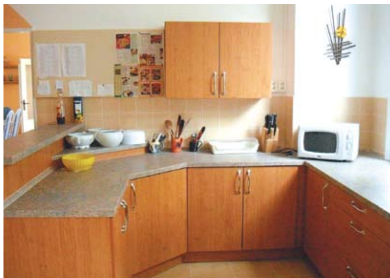
Cvičná kuchyně po rekonstrukci
