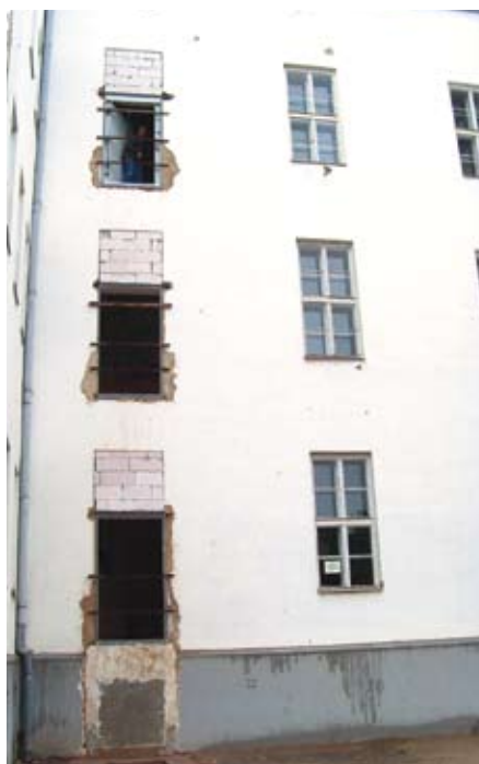
Dveřní otvory pro budoucí vnější výtah ve škole v Ivančicích. Výtah začne sloužit v první polovině října.
