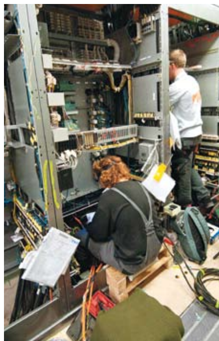
Práce v rozvodných skříních
