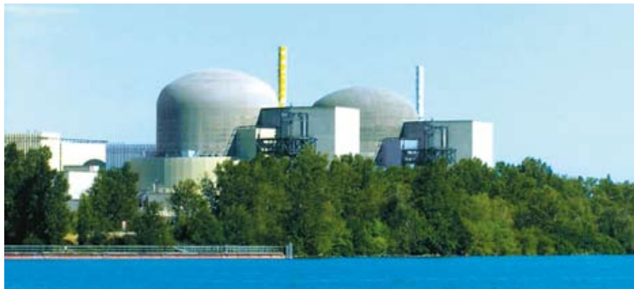
Jaderná elektrárna St. Alban
