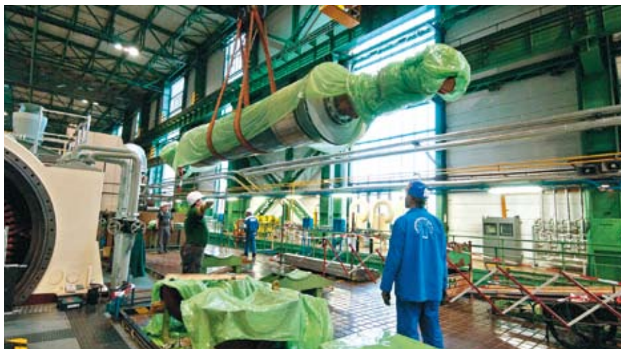
Přeprava rotoru generátoru na strojovně 3. a 4. bloku
