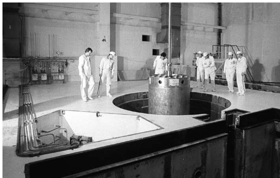
Zavážka paliva do reaktoru 1. bloku začala 31. prosince 1984 a trvala do 17. ledna 1985
