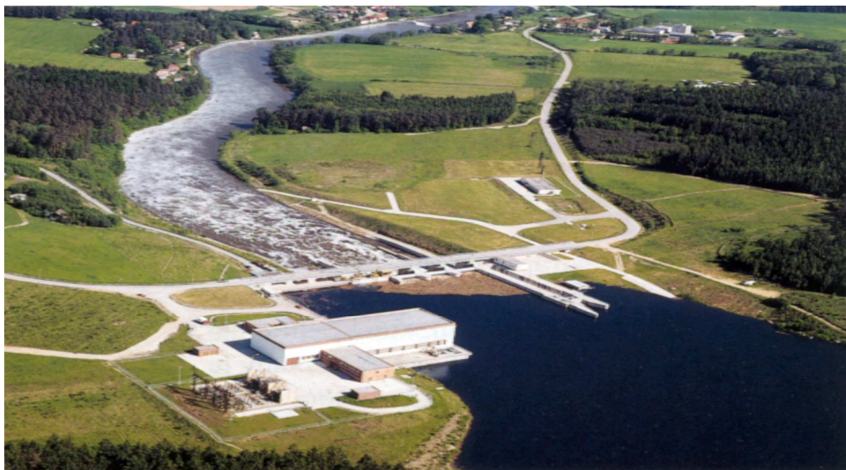
Obr. 3.1.1-3 Vodní dílo Hněvkovice s čerpací stanicí surové vody pro JE
