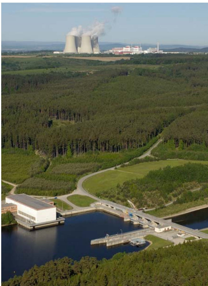
Pohled na vodní elektrárnu Hněvkovice, která je zároveň zásobárnou technologické vody pro Jadernou elektrárnu Temelín.
