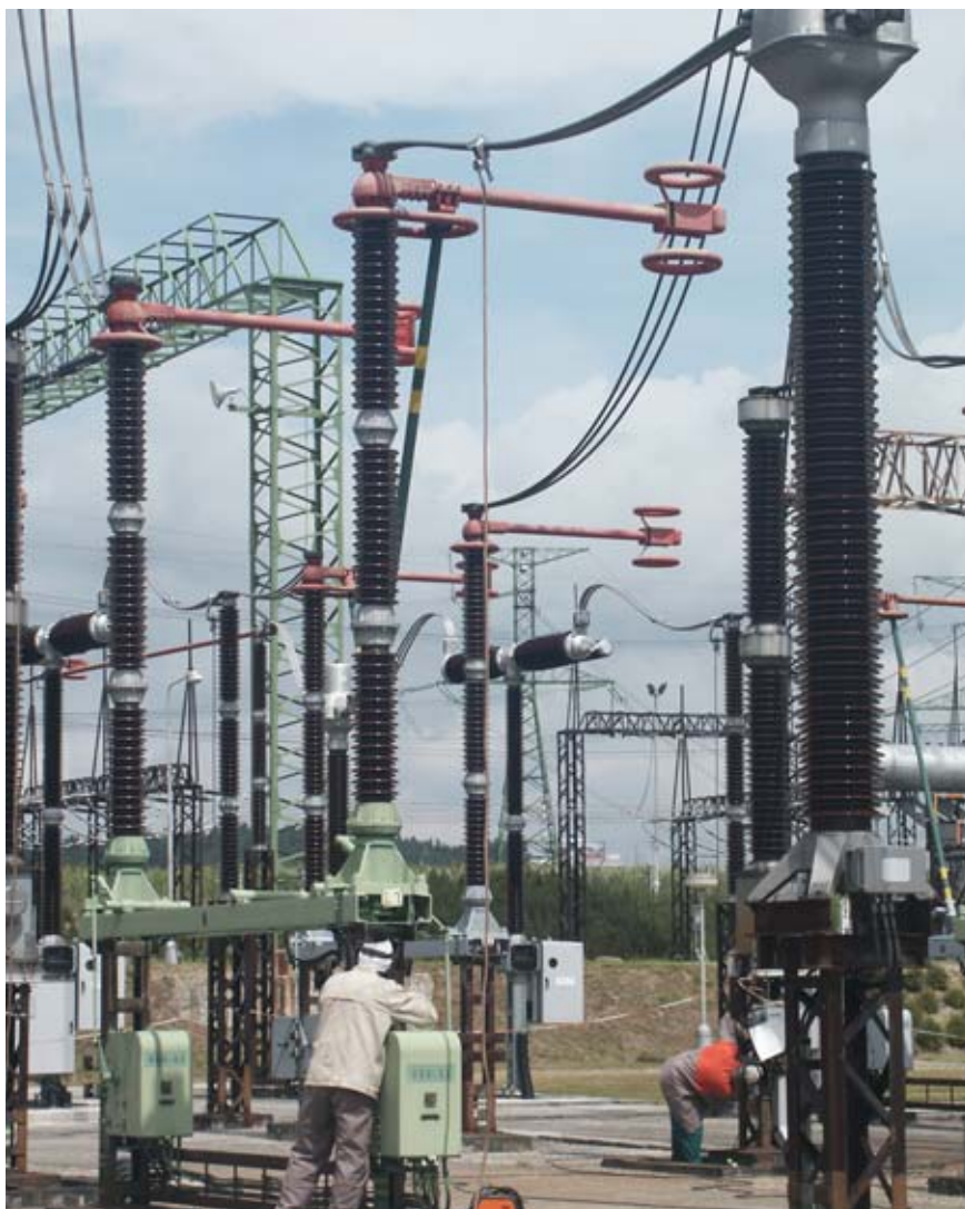
Pravidelná údržba na rozvodně Kočín je jedním z kamínek mozaiky stabilní rozvodné energetické sítě ČR.
