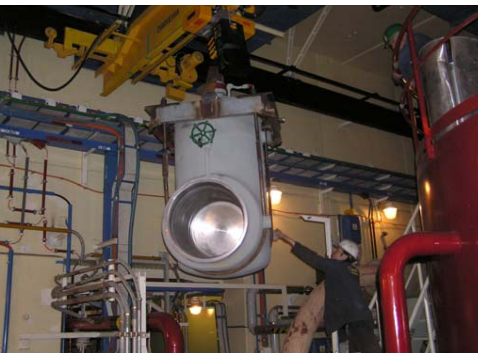
Transport těla nové rychločinné armatury byl v místnosti A820, která je naplněna technologií, velmi náročnou manipulací.
