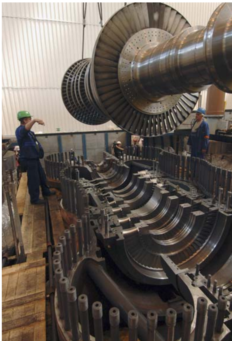
Usazování nového vysokotlakého rotoru turbíny je hodinářská práce.
