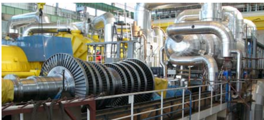
Na prvním bloku dojde při odstávce k výměně vysokotlakého rotoru turbíny.
