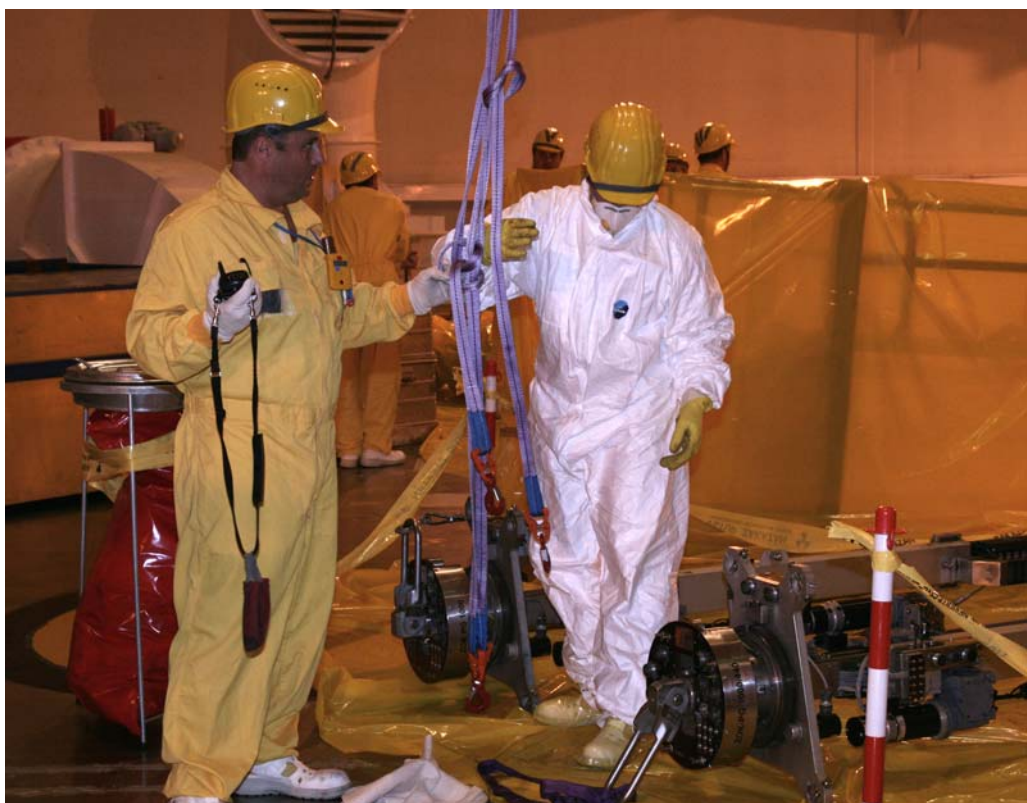
Na závěr odstávky uklázejí pracovníci elektrárny i dodavatele zařízení z reaktorového sálu prvního bloku.
