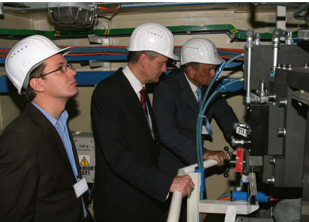
„Legendární místnost A820“ se souběhem energetického potrubí a rychločinnými armaturami si prohlédli poslanec Strany zelených Ondřej Liška (vlevo) spolu s Cyrilem Svobodou a Janem Kasalem z KDU-ČSL.
