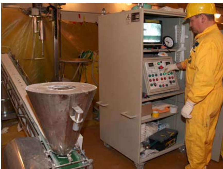
Celý proces zpracování kalů je ovládán z jednoduchého řídicího panelu.
