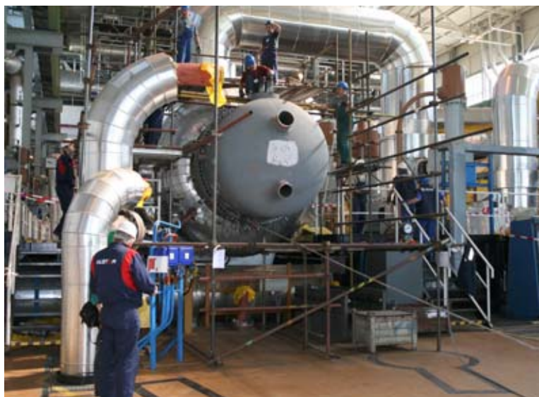
Při letošní odstávce druhého bloku elektrárny Temelín byla provedena i kontrola separátoru u turbogenerátoru.
