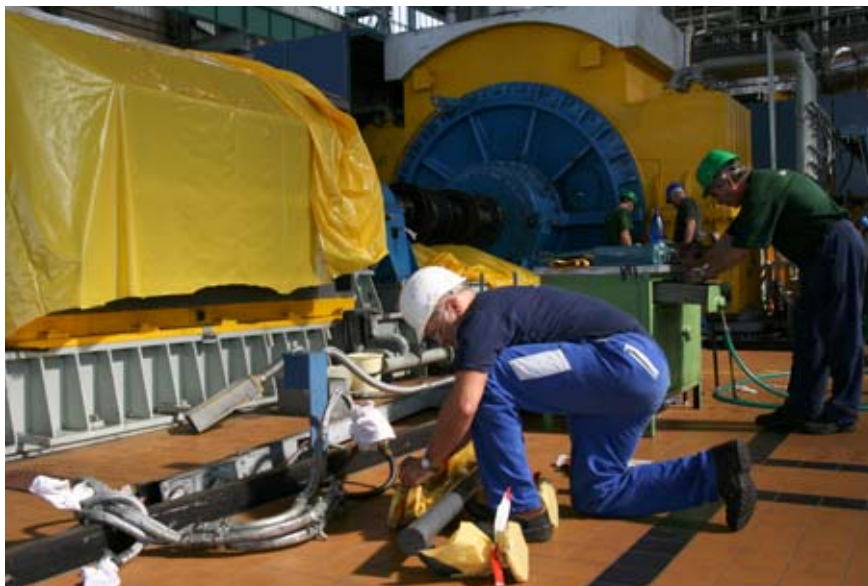
Při odstávce 1. bloku probíhá i šestiletá revize generátoru, při které bude vyměněn jeho rotor.
