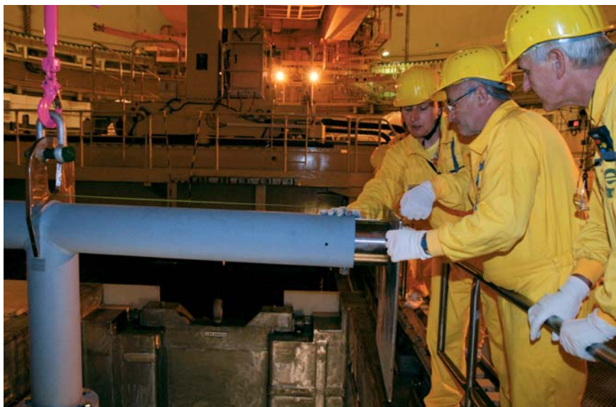
Manipulace s maketou kontejneru CASTOR nad šachtou transportního kontejneru v reaktorovém sále prvního bloku elektrárny Temelín. V pozadí vidíme modernizovaný zavazecí stroj.
