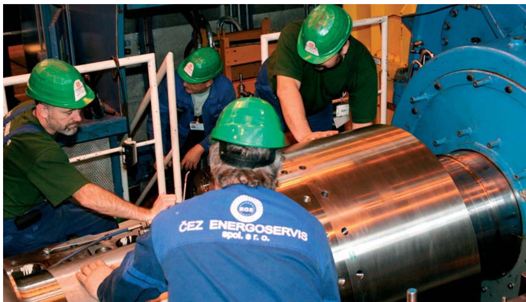
Pracovníci ČEZ ENERGOSERVIS dokončují montáž turbíny na prvním bloku po ukončení kontrol a opravy nízkotlakých rotorů.
