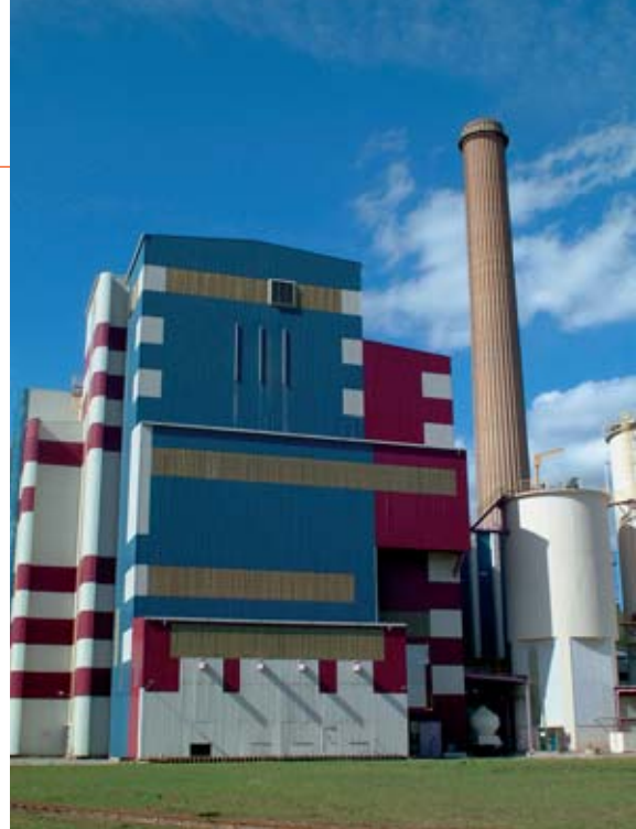
Elektrárna Poříčí - druhý největší výrobce elektřiny z biomasy společnosti ČEZ v České republice
