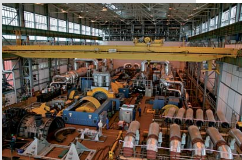
Na druhém bloku elektrárny Temelín pokračuje odstávka pro výměnu čtvrtiny paliva. Velmi důležitou prací je přelopatkování nízkotlakých dílů turbíny. Fotografie nám ukazuje strojovnu, kde probíhají práce na úpravě turbíny. Odstávka druhého bloku skončí v polovině července a od 1. srpna bude zahájena odstávka pro výměnu paliva na prvním bloku.
