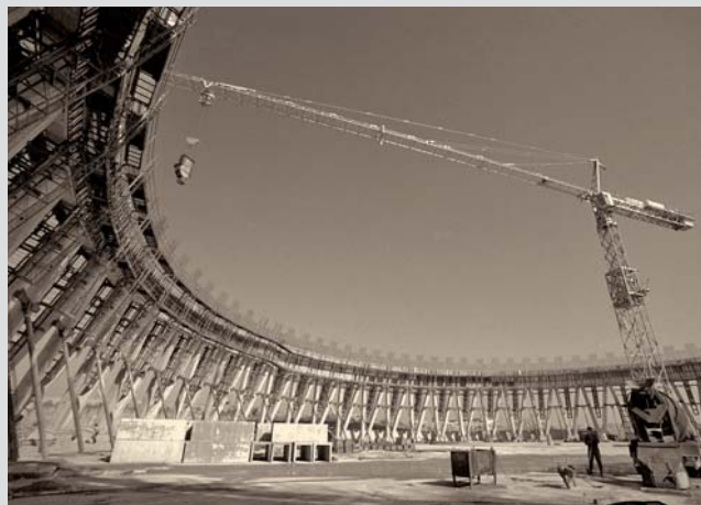
Druhá fotografie nám ukazuje stavbu jedné ze čtyř chladicích věží.
