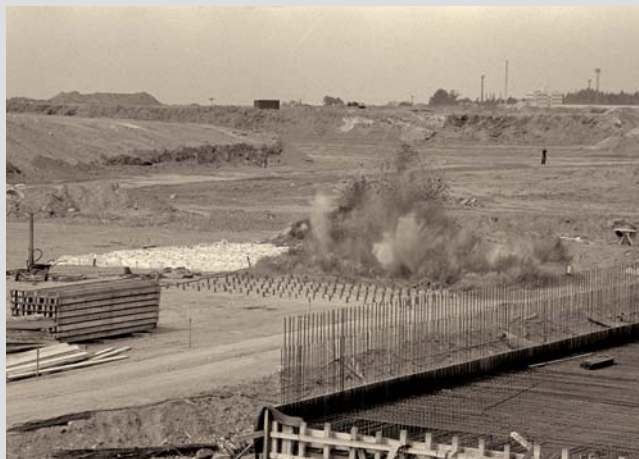
Na první fotografii si připomínáme odstřel horniny pro základovou spáru nejdůležitějších objektů ze začátku výstavby.
