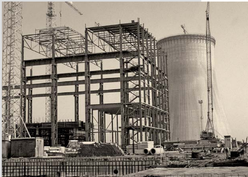
Druhá fotografie nám ukazuje ocelovou konstrukci budoucí strojovny a přes ni vidíme chladicí věž. Takový pohled již na elektrárně není možné přes dokončenou strojovnu vidět.
