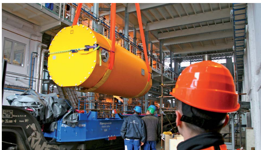
Na speciální vagón se první „temelínský“ CASTOR nakládal v přepravním koridoru pod strojovnou 1. bloku. Manipulace s dalšími obalovými soubory na Temelíně již budou probíhat v novém skladu použitého paliva.
