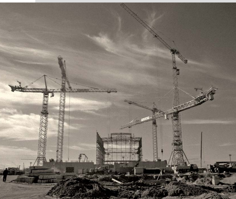
První fotografie nám ukazuje ocelovou konstrukci budoucí strojovny 1. bloku.
