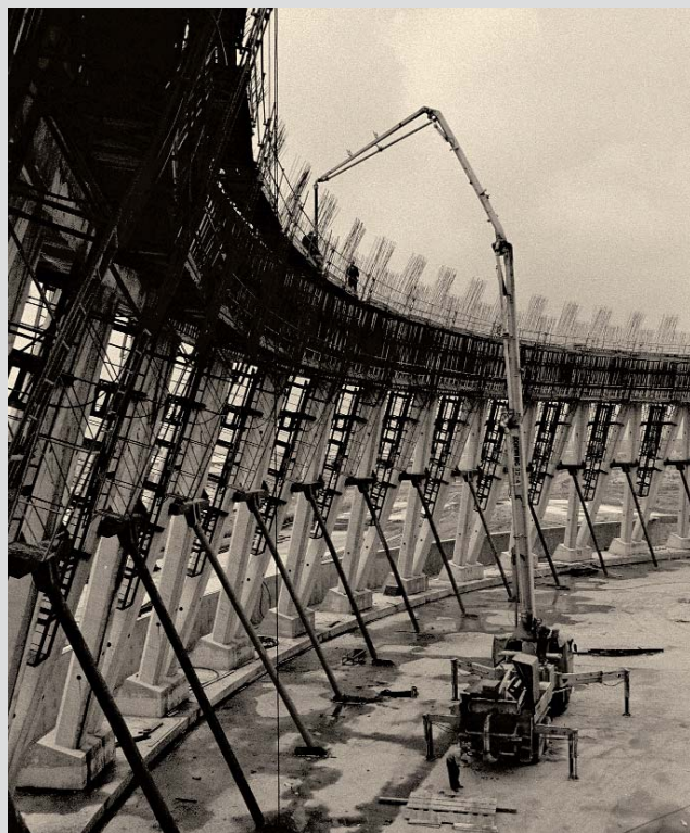
Na druhé fotografii vidíme betonáž spodního prstence první chladicí věže JE Temelín. Ta byla stavebně dokončena v říjnu 1988.
