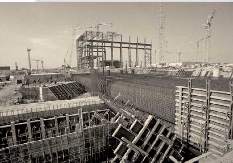
Na první fotografii vidíte montáž potrubí chladicí vody.
