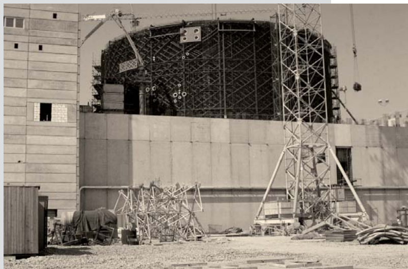
Druhá fotografie nám ukazuje ocelovou konstrukci budoucího kontejneru 1. bloku.
