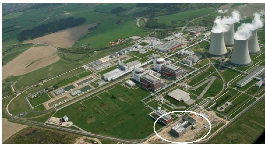
Pro dočasné skladování vyhořelého paliva z provozu temelínských bloků byl postaven suchý sklad na použité palivo přímo v areálu elektrárny Temelín. Sklad má kapacitu 1 370 tun, tj. na palivo, které bude pracovat po dobu 30 let v reaktorech JE Temelín. První použité palivo bude do skladu zavezeno v kontejnerech CASTOR letos na začátku září.
