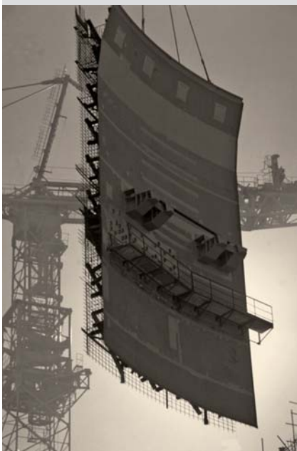
Přeprava jednoho z dílů při montáži kontejnmentu 1. bloku
