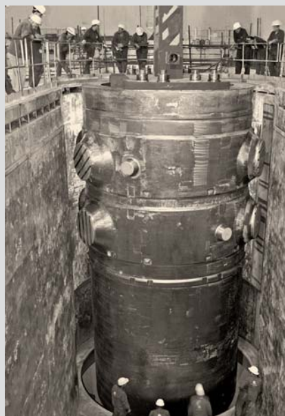
Pohled do reaktorového sálu prvního bloku JE Temelín při usazování tlakové nádoby reaktoru do šachty
