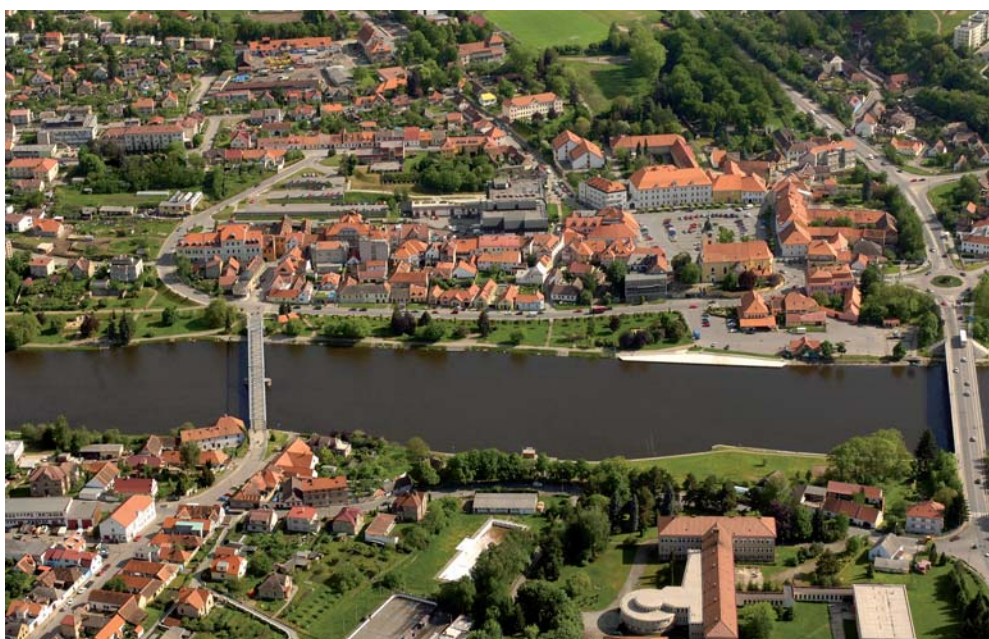
Příprava místních opatření na průtahu Týnem je nejdále. První akcí, která půjde do realizace, bude výstavba druhého výjezdu ze sídliště Hlinecká, který je připraven projekčně a město čeká na stavební povolení.
