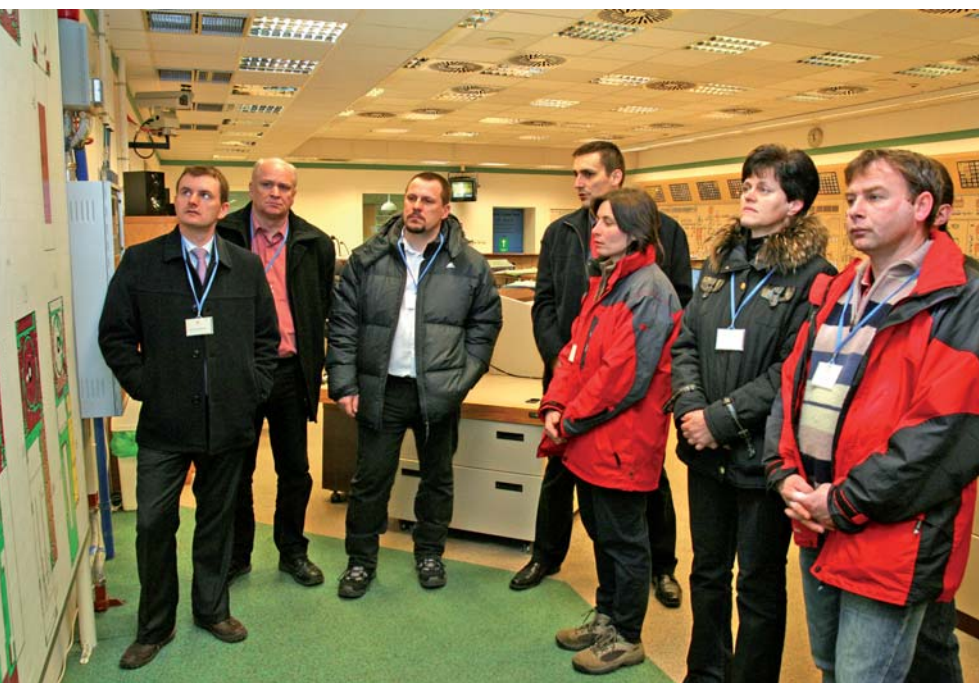
Prohlídka blokové dozorny prvního bloku elektrárny Temelín
