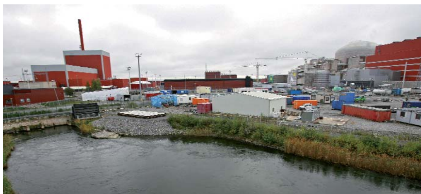
Pohled na stavbu Olkiluoto 3. Blok by měl začít dodávat elektřinu do sítě v roce 2013.
