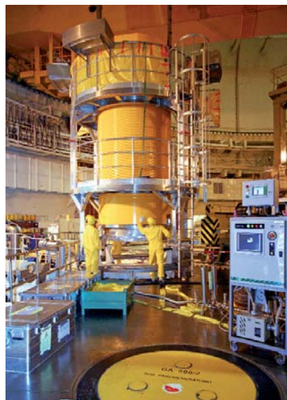
Pohled na kontejner CASTOR při jeho ukládání na servisní místo v reaktorovém sále
