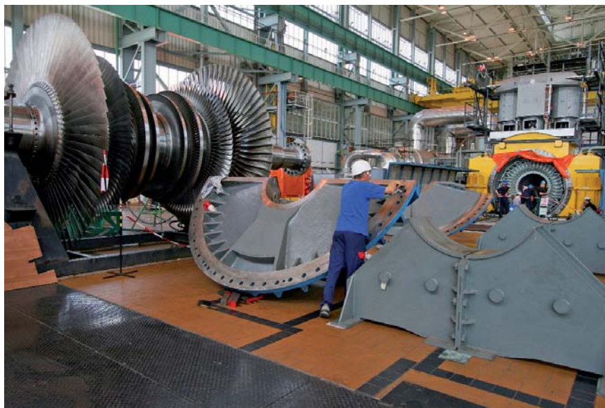
Pohled do strojovny při odstávce prvního bloku. Na levé straně je vidět jeden ze tří nízkotlakých rotorů turbíny, na kterých se každoročně provádí kontrola.
