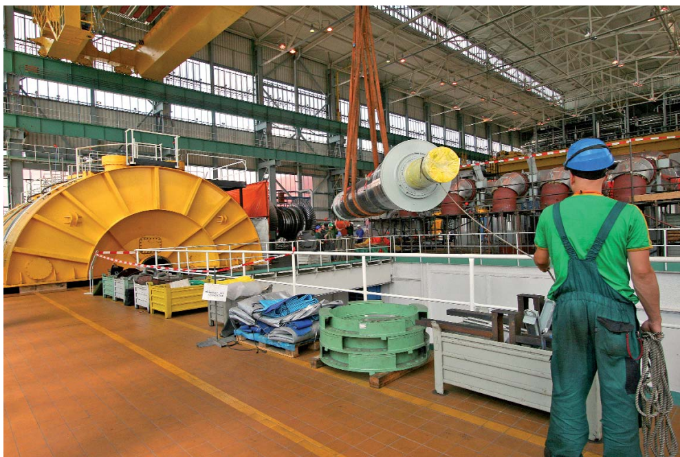
Jednou z nejdůležitějších prací při odstávce prvního bloku je výměna rotoru generátoru a jeho kontrola. Na snímku je vidět transport rotoru generátoru ven ze strojovny.
