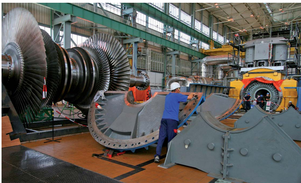
Při letošní odstávce na prvním bloku byla nejrozsáhlejší činností výměna rotoru generátoru.
