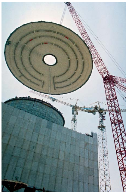
Osazení vrchlíku kontejnmentu byla pro staveře velmi náročnou transportní operací. Na spodní části je dobře vidět připravený havarijní sprchový systém kontejnmentu.
