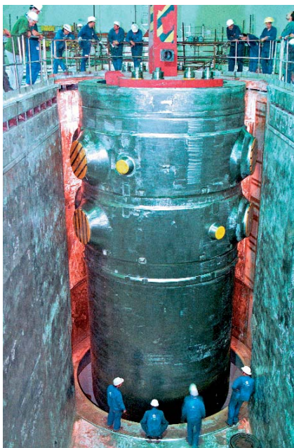
Unikátní pohled na osazení tlakové nádoby reaktoru. Její výška je 10,9 metru, průměr 4,5 metru a tloušťka stěny 200 milimetrů.
