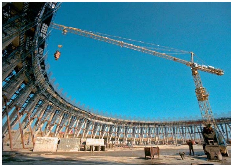
Stavba současné temelínské dominanty, tedy jedné ze čtyř chladicích věží. Každá je vysoká 155 metrů a jejich průměr v patě je 130 metrů.
