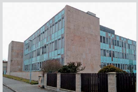
Poliklinika v Týně nad Vltavou letos projde další etapou úpravy. Na pravé fotografii nám ukazuje již renovované čelo polikliniky s výhledem na vltavotýnskou ulici.
