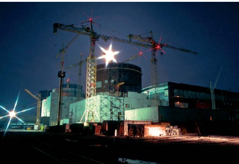
Ve svém vrcholu probíhaly stavební práce na hlavních objektech v nepřetržitém provozu. Fotografie ukazuje stavbu kontejnmentů.
