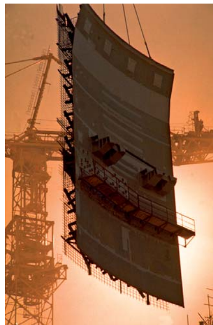
Zdvíhání jednoho z připravených dílů kontejnmentu
