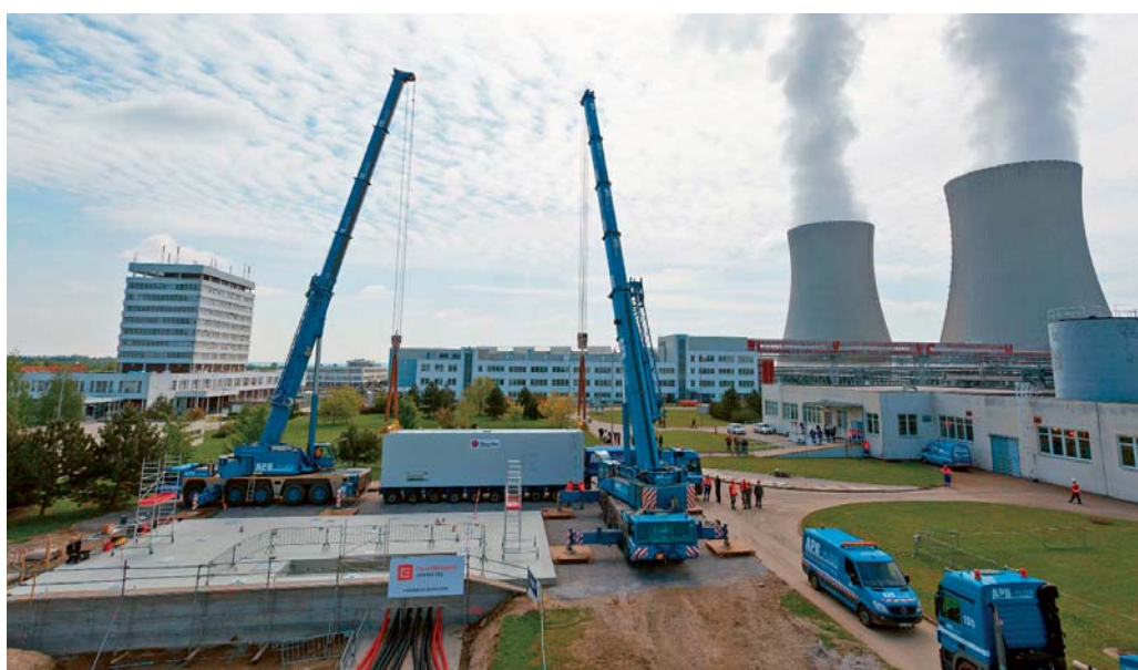
Osazení kontejneru s novým dieselgenerátorem, který vážil 130 tun, musely provést dva jeřáby.
