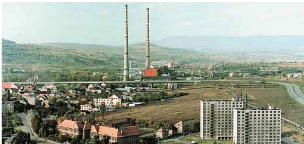
■ Celkový pohled na Teplárnu Trmice v roce 1993
