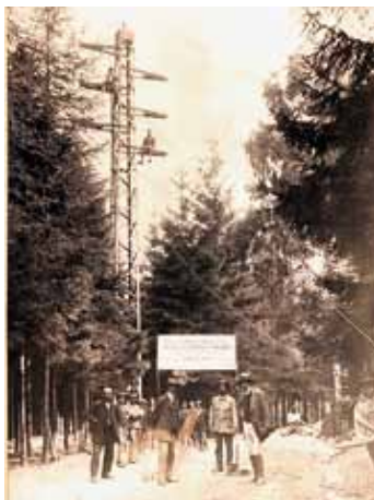
▣ Stavba elektrorozvodů v okolí Trmic
