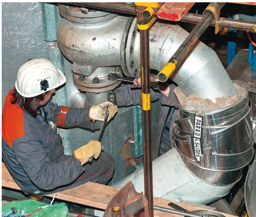
Práce na strojně při odstávce 4. bloku
