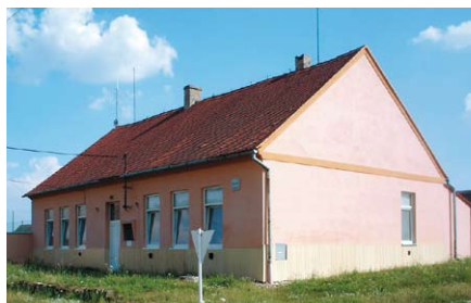
Zrekonstruovaná budova bývalé školy ve Stupešicích
