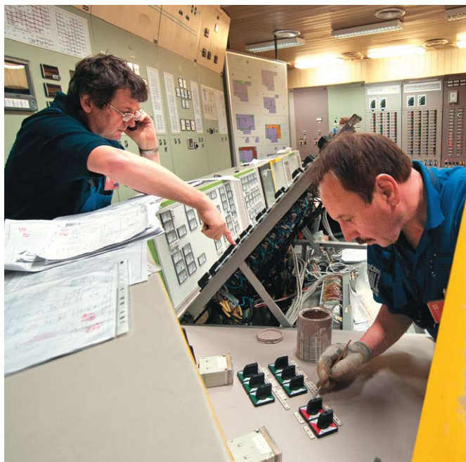
K náročným úkolům roku 2010 patřila odstávka 4. bloku, na jejímž konci dosáhl blok výkonu 500 MW. Na snímku práce na rekonstrukci blokové dozorny.
