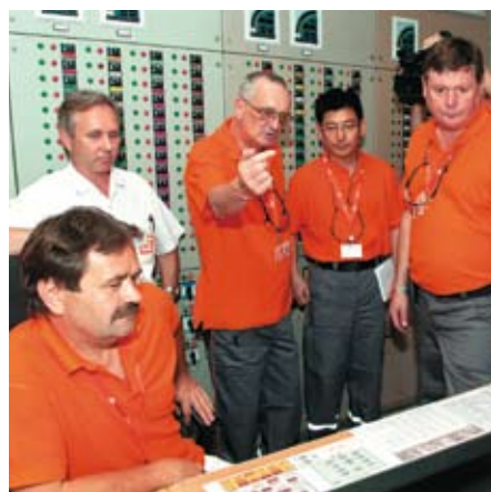
Na blokové dozorně
