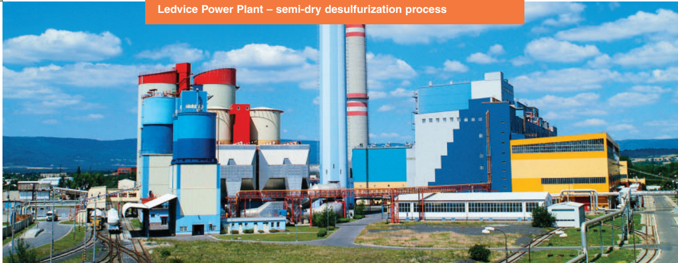
Elektrárna Ledvice – technologie polosuchého odsíření Ledvice Power Plant – semi-dry desulfurization process
