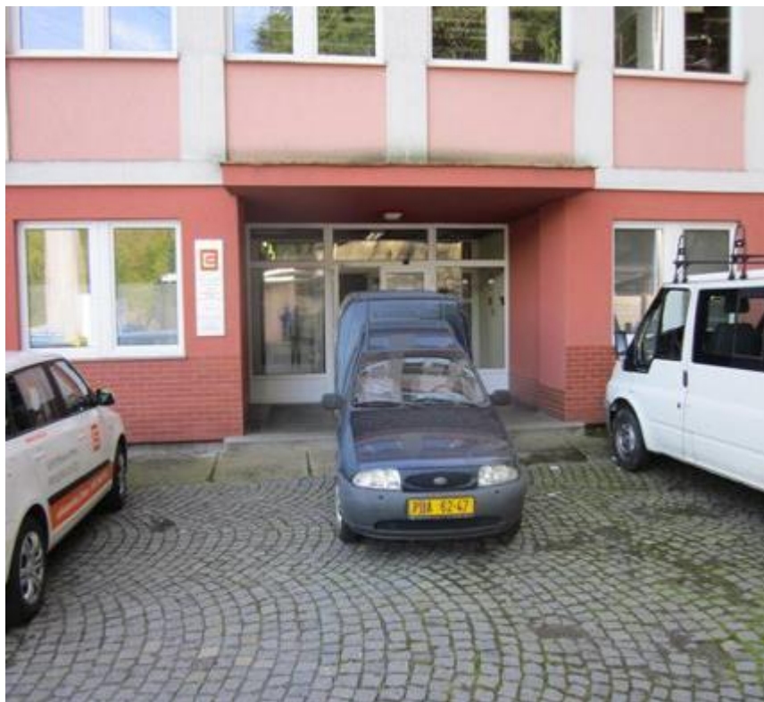
Vstup do správní budovy
