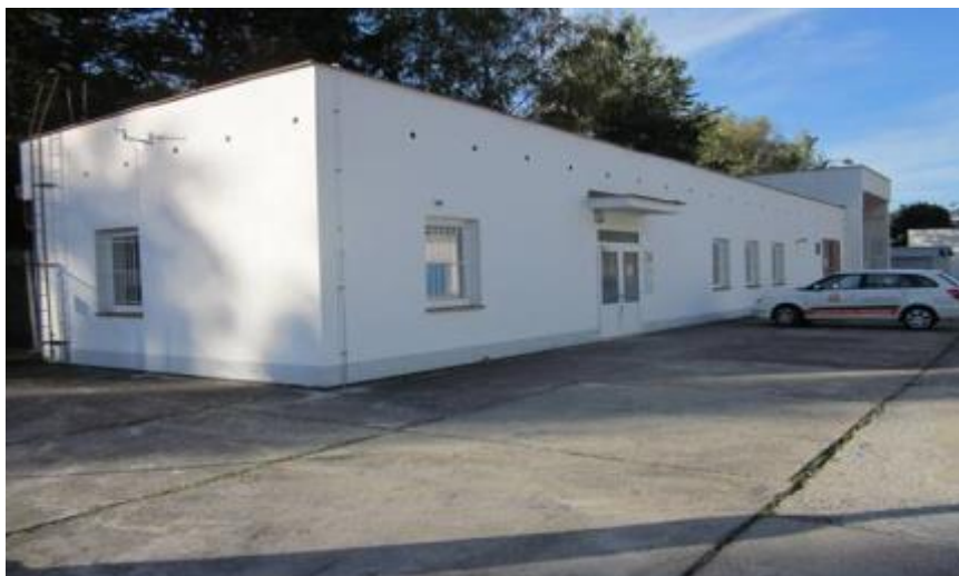
Vstup do správní budovy elektrárny EKO
