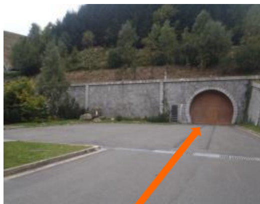
Vstup do podzemní elektrárny
