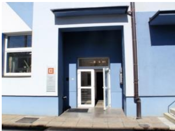
Vstup do provozní budovy a velín
