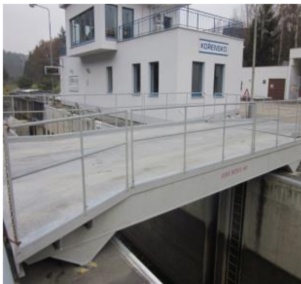
Přechod a přejezd přes plavební komoru
