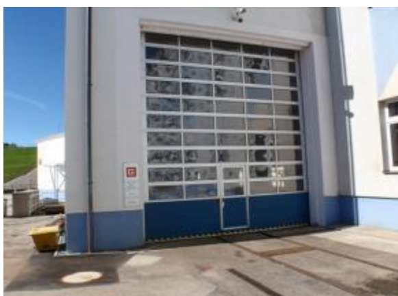
Vstup do strojovny ŠNV
