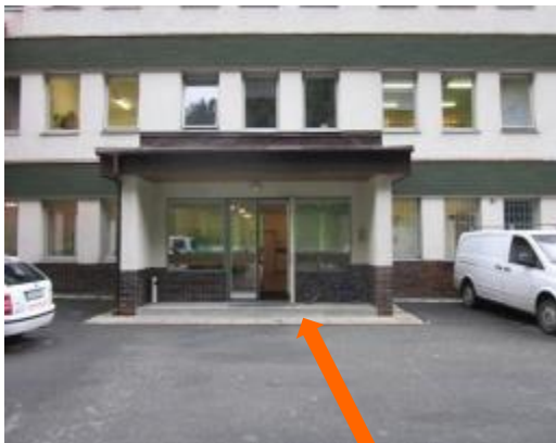
Vstup do správní budovy
