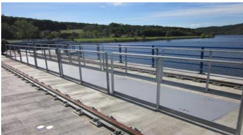
Místo hrazení na vtokovém objektu
