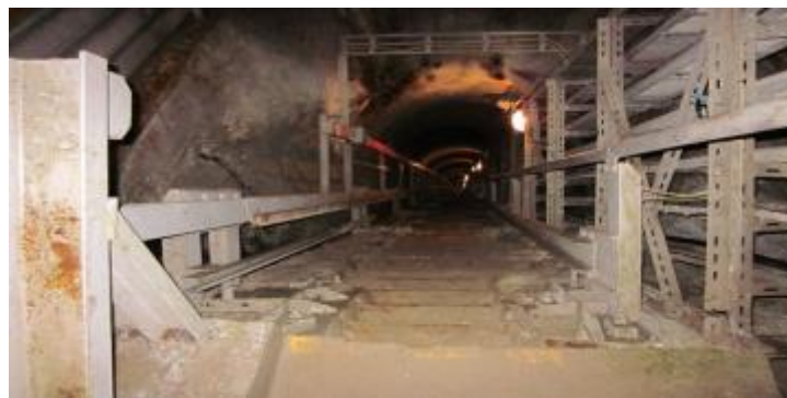
Schodiště pod výtahem na HN
