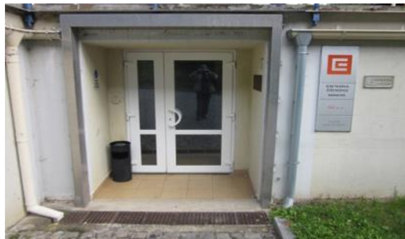
Vchod do strojovny EST II
