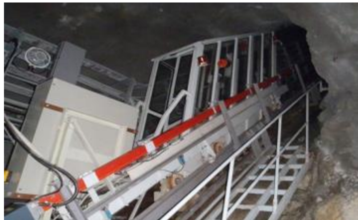
Přístup k výtahu na HN
