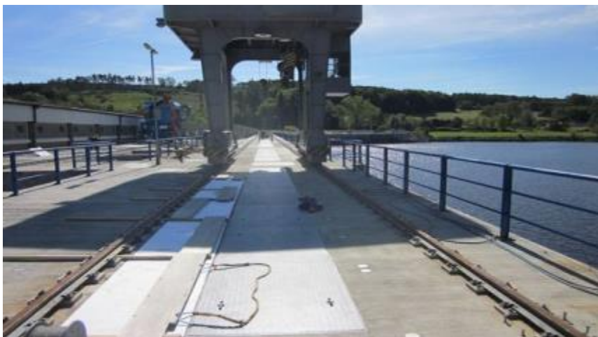
Hradidlový jeřáb na vtokovém objektu
