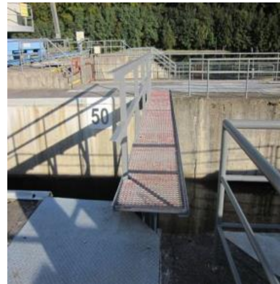
Přechod přes plavební komoru
