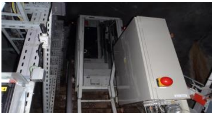
Kabina výtahu na HN
