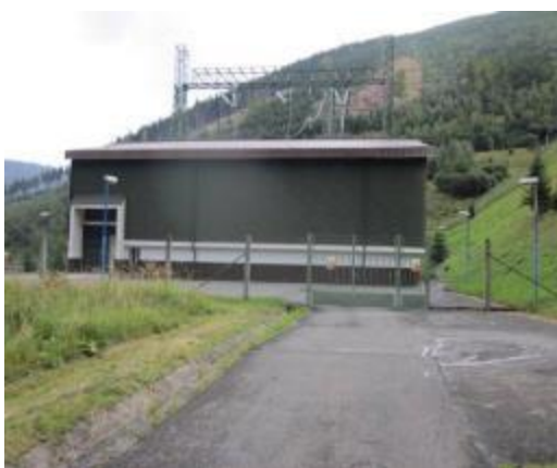
Vstup do rozvodny 400kV a vývodové pole
