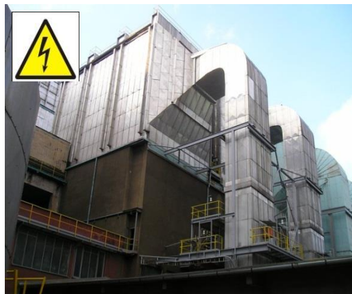
Elektrofiltry (vn)
