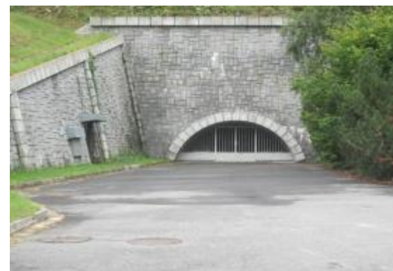
Vstup do injekční štol a přístupové štol
