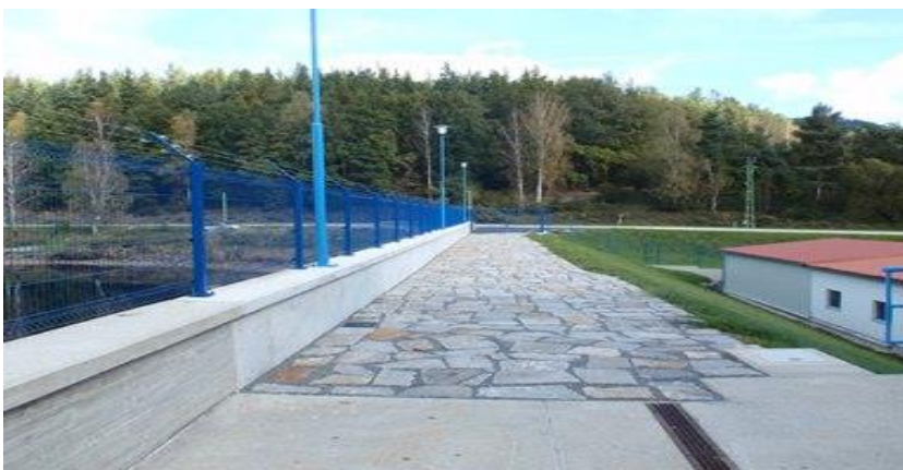
Vstup na korunu hráze ze strany hlavní komunikace
