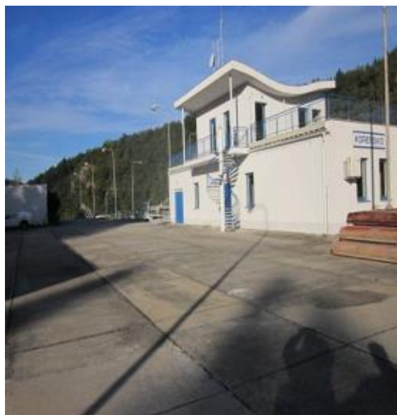
Strojovna a velín obsluhy plavební komory
