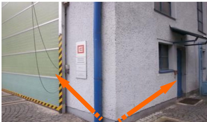
Vchod do strojovny EST I
