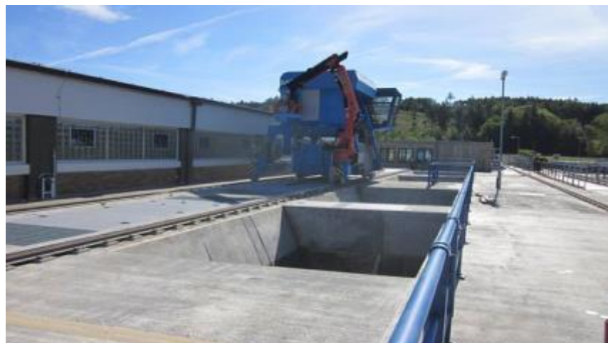
Čistící stroj na vtokovém objektu
