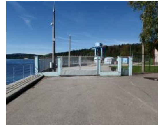
Vstup do vtokového objektu
