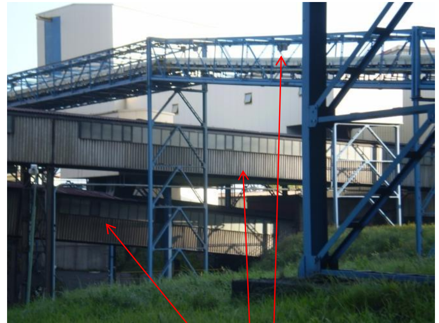
Dopravníky uhlí jsou zakryté
