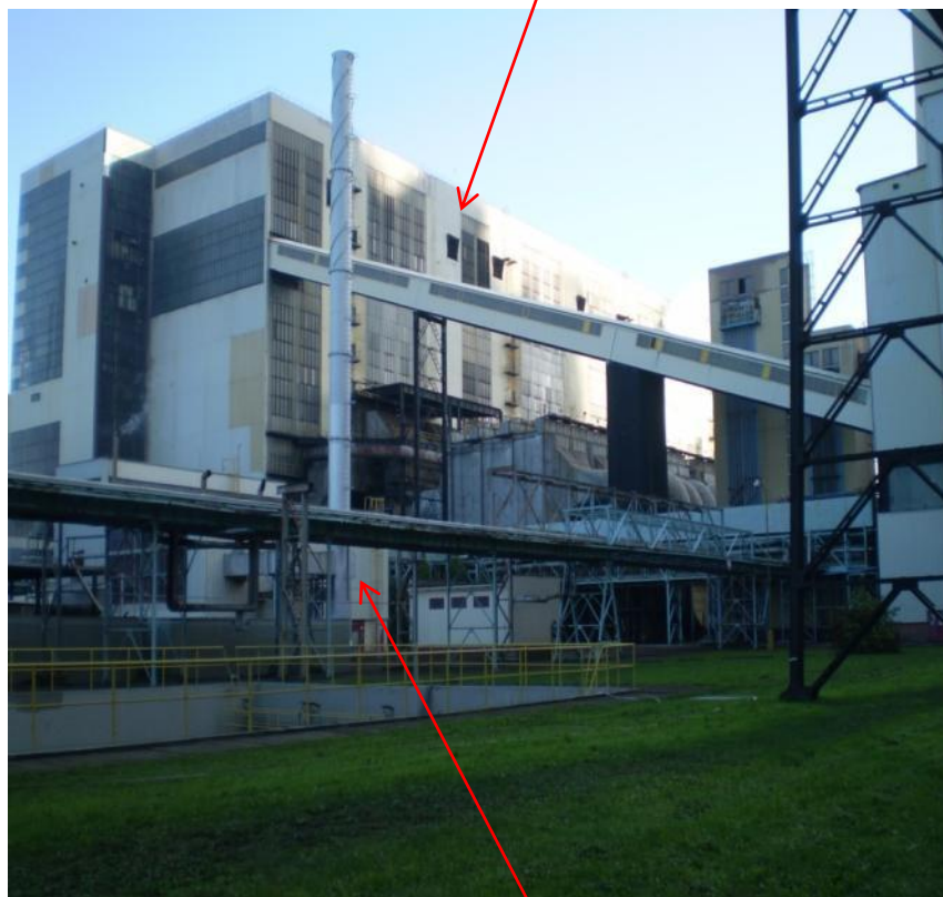
Malá mazutová pomocná kotelna
