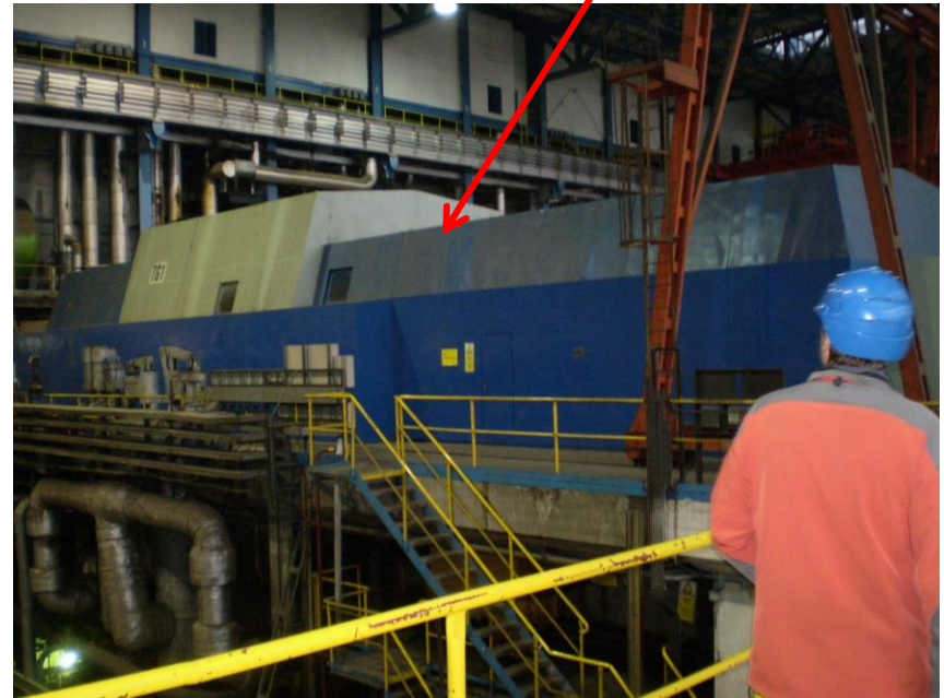
Parní turbína s generátorem
