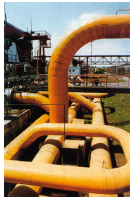
Kompresorová stanice vtačující zemní plyn do podzemního skladu
