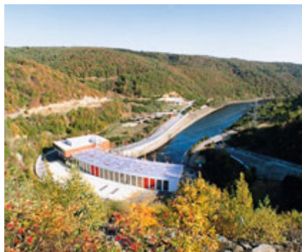
Přečerpávací vodní elektrárna Dalešice
