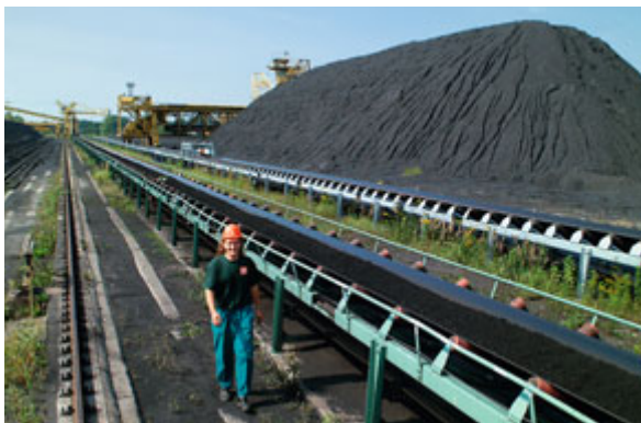
Skládka uhlí v Elektrárně Dětmorovice
