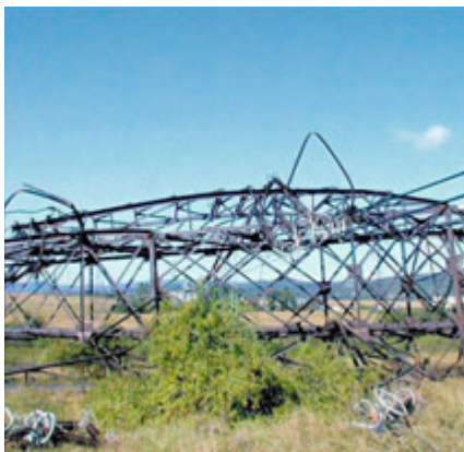
Co dokáže udělat vichřice se stožáry vysokého napětí
