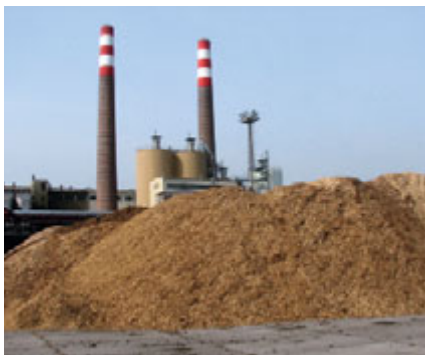
Skládka biomasy v Elektrárně Hodonín
