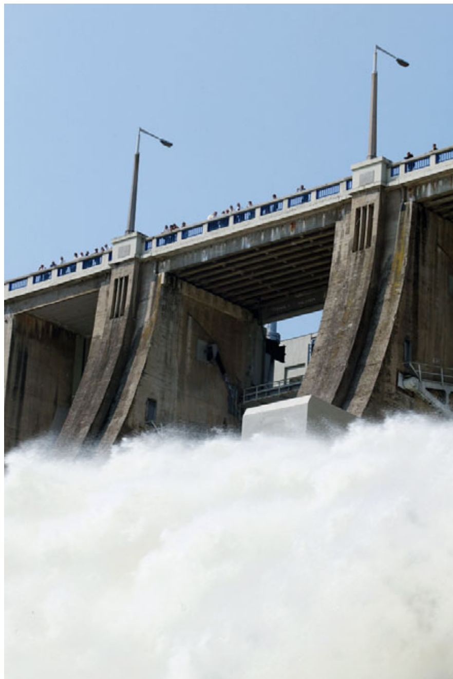
Vodní elektrárna Slapy
