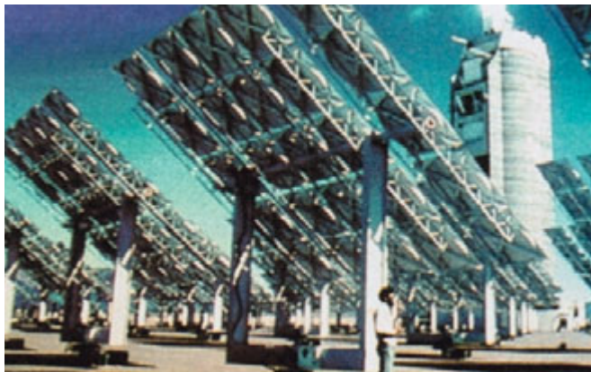
Sluneční tepelná elektrárna
