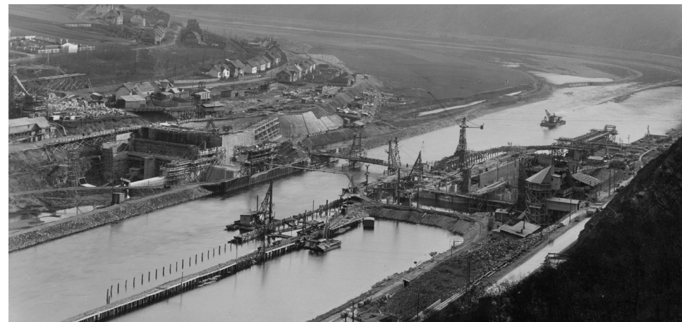
■ Stavba zdymadla ve Vraném n. Vltavou
