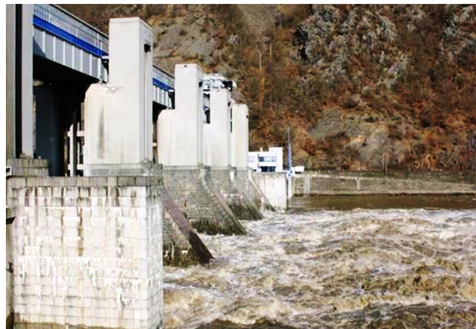
■ Šedesát let sloužila stará rozvodna ■ než byla nahrazena novou, moderní, ekologickou a bezpečnou ■ Zdrojem energie je dvojice Kaplanových turbín ■ Vyzvedávání turbíny při opravách soustrojí TG2 ■ Vodní dílo a elektrárna opakovaně čelily velké vodě
