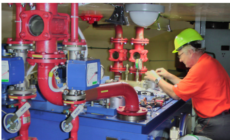
■ Práce specialistů na regulační části soustrojí TG2
