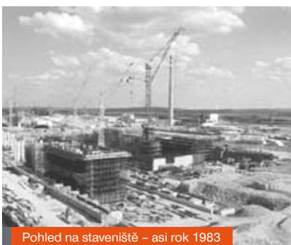
Pohled na staveniště – asi rok 1983
