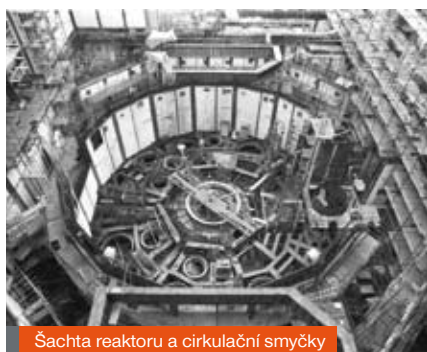
Šachta reaktoru a cirkulační smyčky
