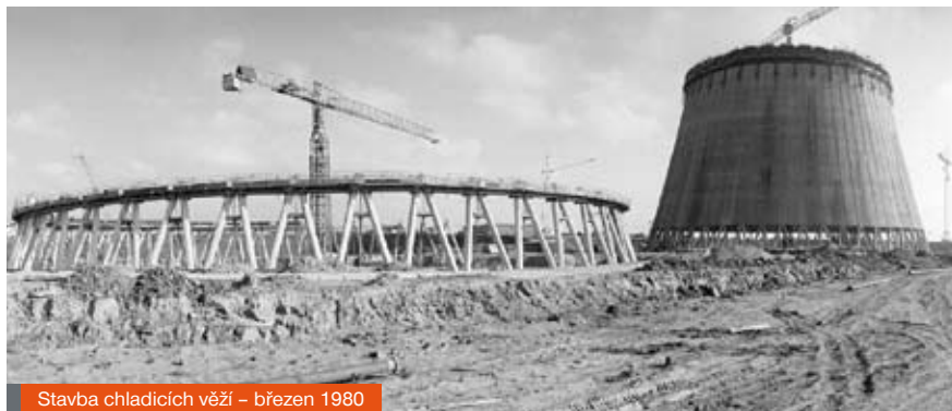
Stavba chladičích věží – březen 1980
