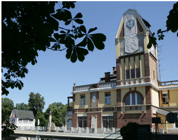
Historická budova elektrárny Hučák zve k návštěvě!
